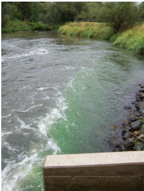
Abbildung 7: Leitströmung aus dem Mäanderfischpass
